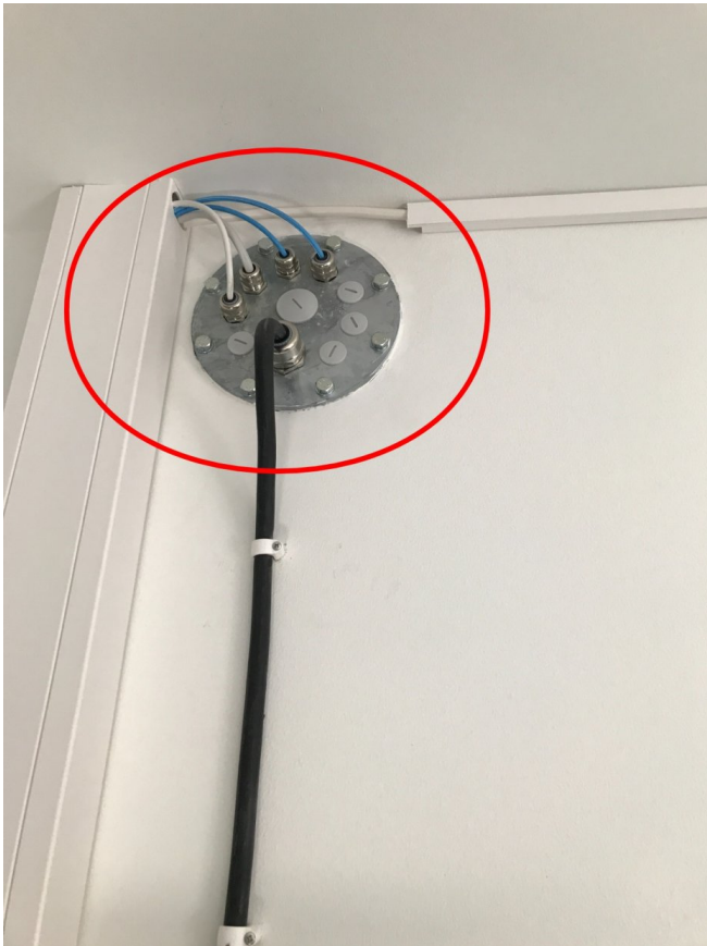
Kotelointi puuttuu
