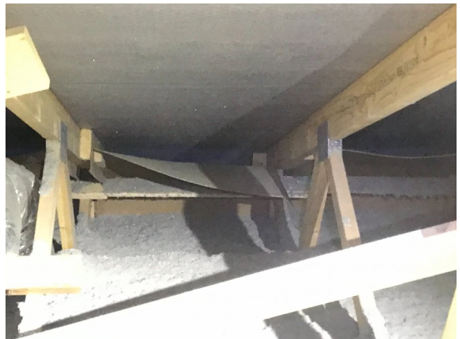
Tuulenojainpahvi oli irronnut toiselta puolen
